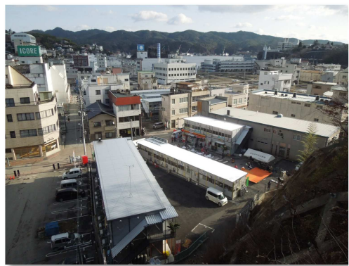
仮設商店街が7棟建つ
