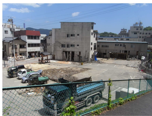
建設前の敷地
